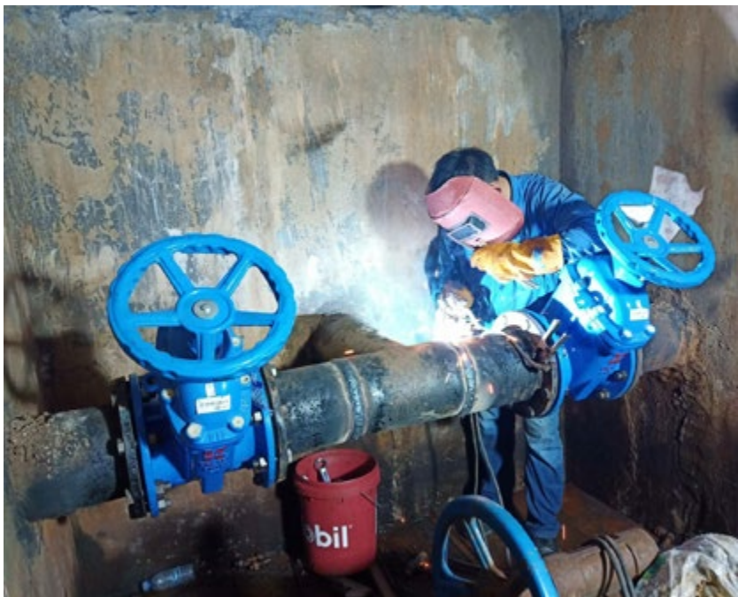
方林军正在焊接供水管道
